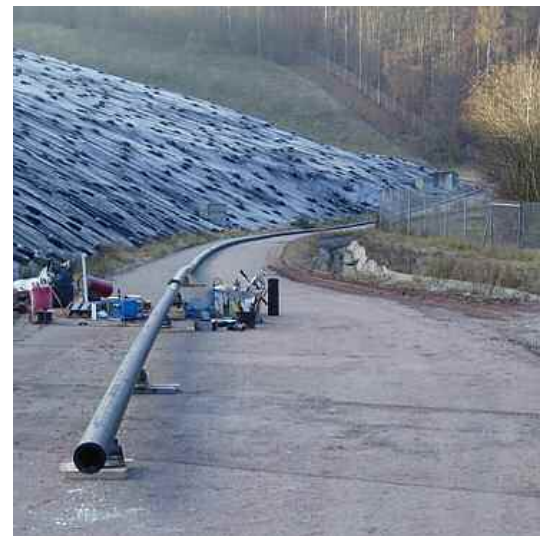
Abbildung 14 und 15: Zugkopf und auf der gesamten Länge vorab verschweißtes Reliningrohr
