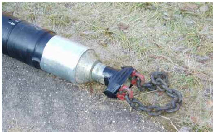
Abbildung 14 und 15: Zugkopf und auf der gesamten Länge vorab verschweißtes Reliningrohr
