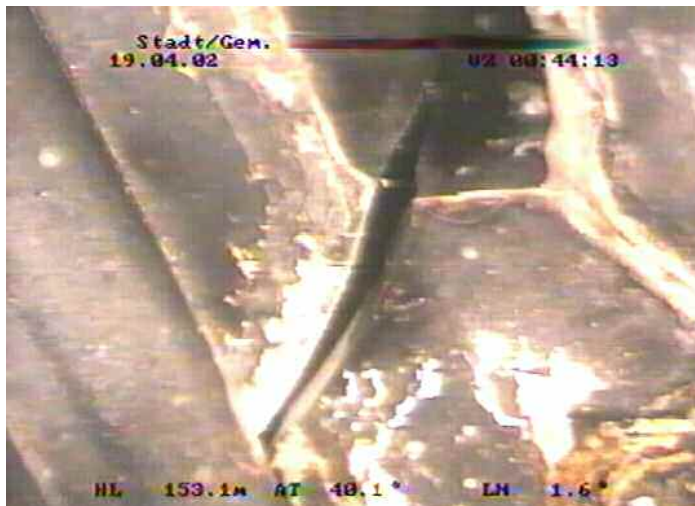
Abbildung 4 An einem Drainageschlitz beginnende Rissbildung
