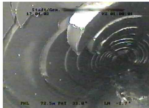
Abbildung 8 und 9 Einsturz einer gelochten und geschlitzten PE-Leitung
