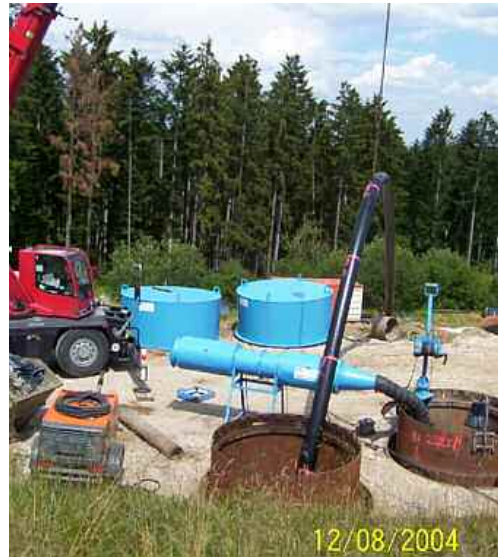
Abbildung 12 und 13 Schneidkopf und Baugrube für die Durchführung des PE-Berstens
